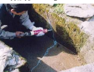
水路のひび割れ補修
