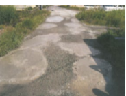
農道の窪みの補修
