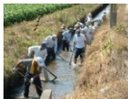
水路の泥上げ
