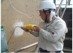
老朽化した施設の機能診断
