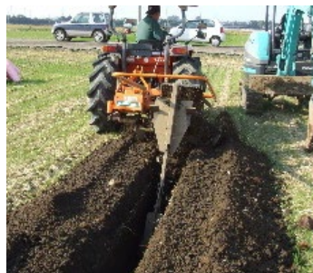
暗渠排水の整備
