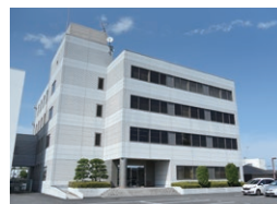
茨城県JA総合情報センター 水戸市小吹町 2461-1
